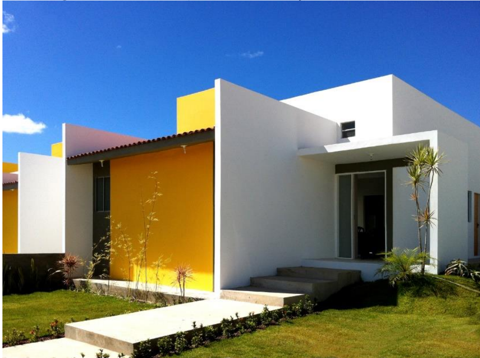
Figura 24 – Fachada posterior - Habitação Social Wirton Lira
