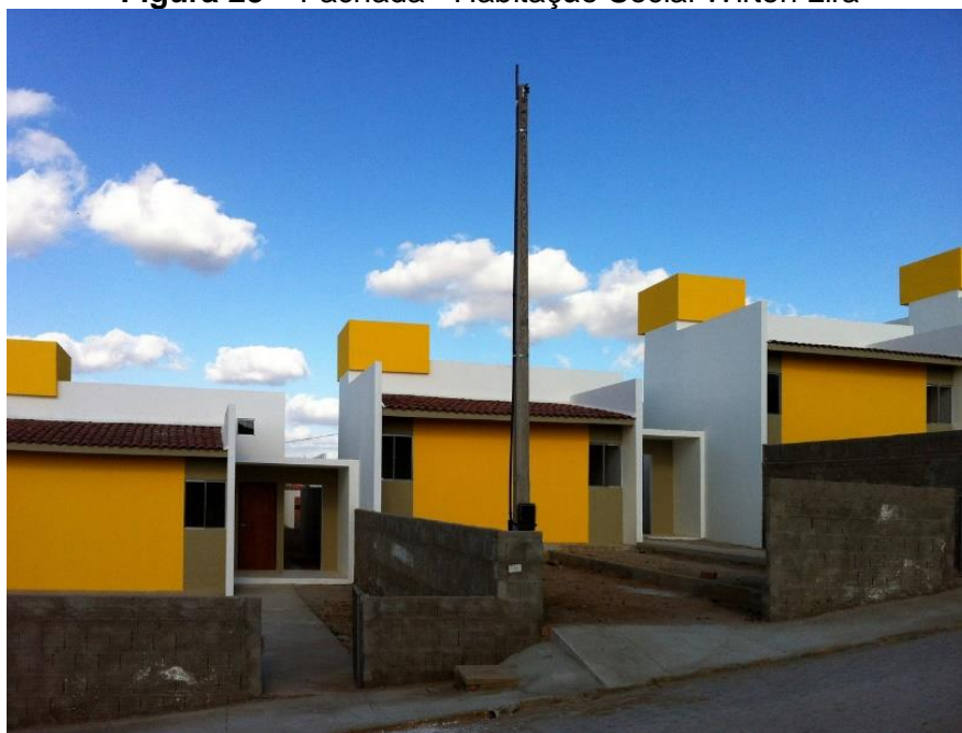
Figura 23 – Fachada - Habitação Social Wirton Lira
