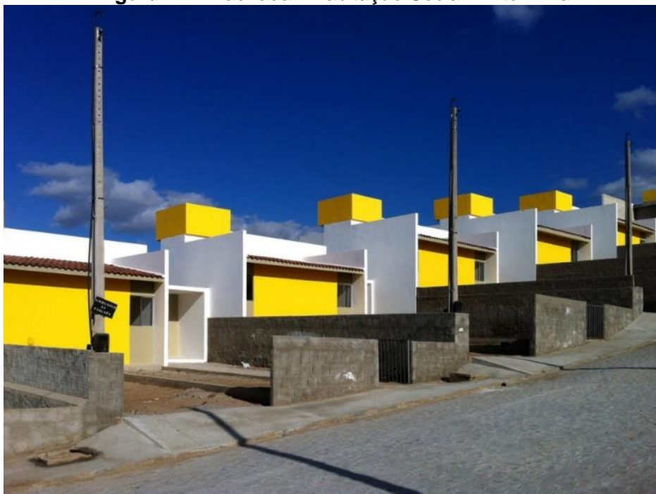
Figura 22 – Fachada - Habitação Social Wirton Lira
